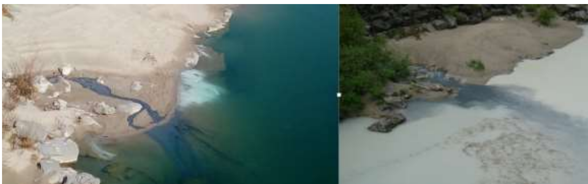
Slika 8 Izcejanje snovi na dnu nasipa industrijske cone Anhovo v reko Sočo. Levo v obdobju brez večjih padavin, desno v obdobju padavin. Foto: vir Eko Anhovo (sliki sta sicer posneti južno od tehnološkega črpališča).
